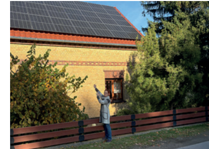
Das Eigenheim mit der neuen PV-Anlage
