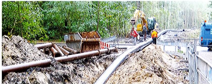
Sanierung/Neuverlegung des Schmutzwasserhauptsammlers vom Kreisverkehr Sachsendammbis zur Kläranlage Halbendorfer Weg in Weißwasser
