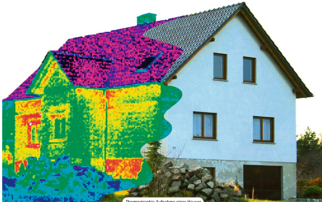
Thermographie-Aufnahme eines Hauses
