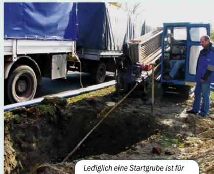
Lediglich eine Startgrube ist für die Verlegung der Rohre noch nötig
