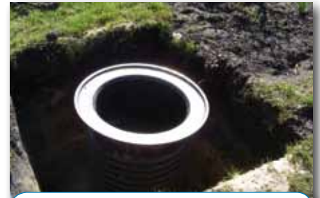
Einbau eines Revisionschachtes an der Grundstücksgrenze, wie er auf jedem anzuschließenden Grundstück in Abstimmung mit den Eigentümern gesetzt wird.
