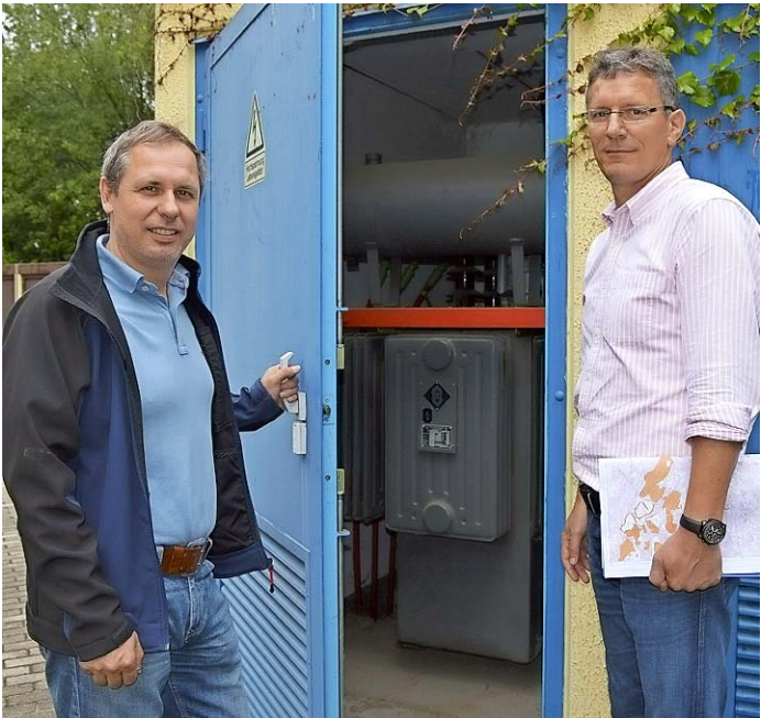
Marco Hülse und René Marko sind während der Leiterbereitschaft als Leiter des Bereitschaftsdienstes nicht nur für Trafostationen, sondern für alle Anlagen im Gebiet der Stadtwerke verantwortlich. Foto: chk
